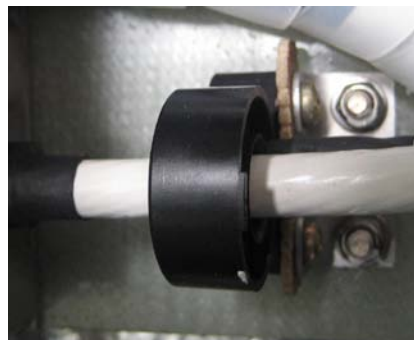
Рис. 6. Индукционный датчик
